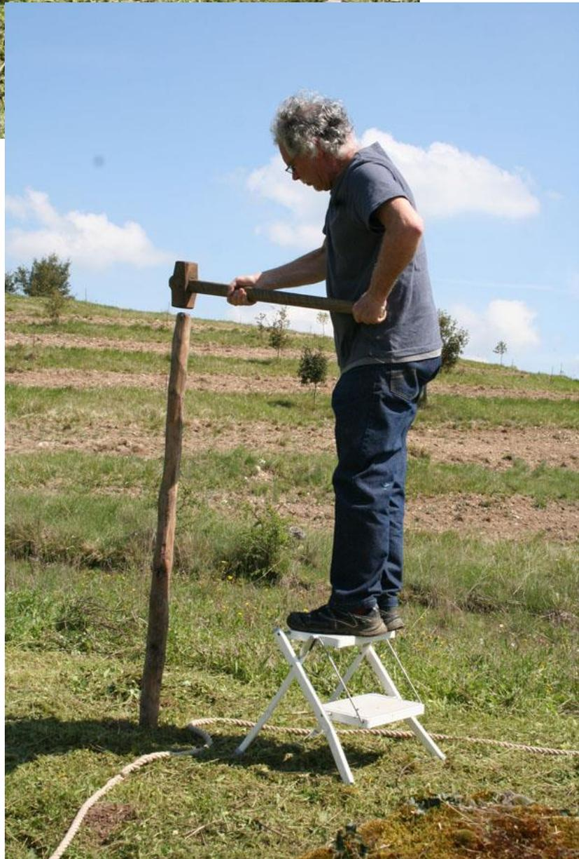
Pré-trous à la barre à mine pour les piquets d'acacia... et masse pour les enfoncer !
